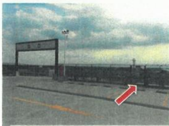
非常階段の出入口 (屋上)
